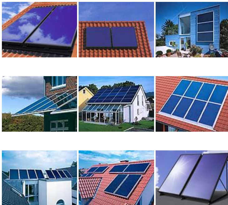
Figura 4 – Exemplos de instalação de colectores solares térmicos
