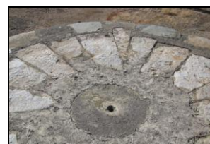
Pormenor da plataforma superior de um antigo moinho de vento
